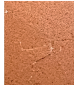
Foto 11. Fisura tipo cabello.
